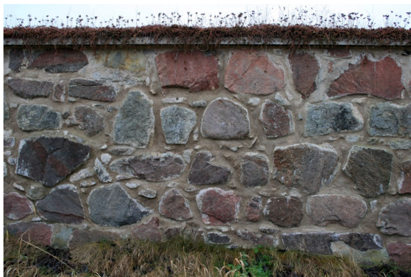
Figur 5.4. En av ringmurens insidor vilka alla är byggda av gråsten.
