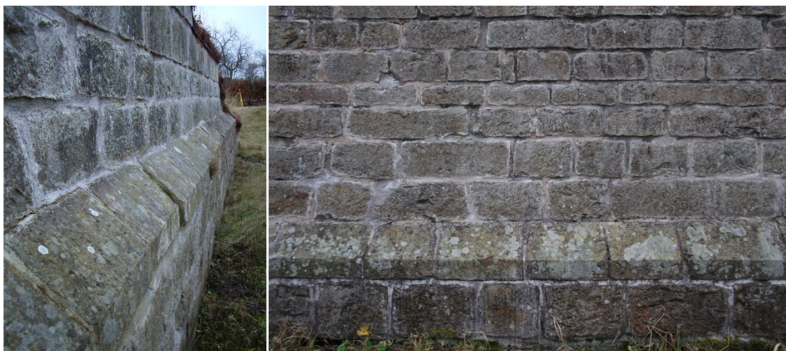
Figur 5.3. Släta och skickligt uthuggna kvaderstenar från huvudborgen. Lägg märke till sockel i nedre kanten.
